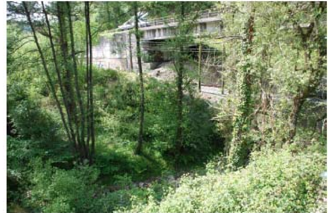
Cruce del ferrocarril en Zugastieta. Se observa la degradación de la vegetación de ribera en esta zona
