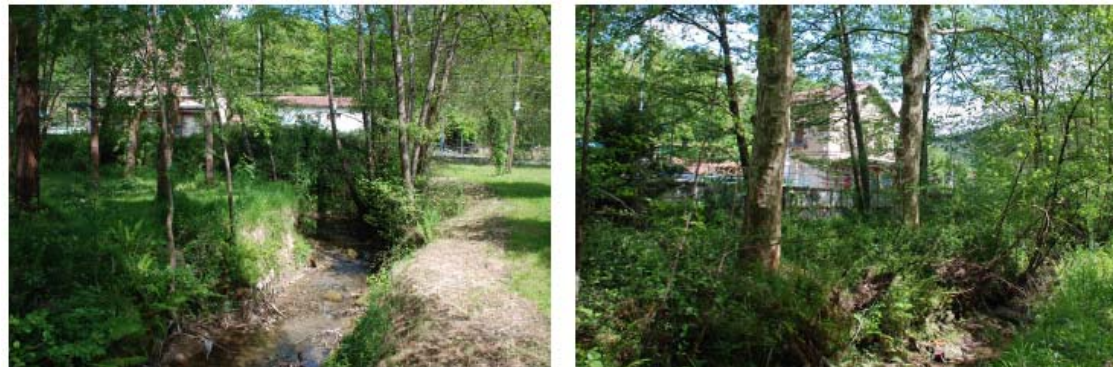
Río Oka a la altura de la FFCC de Zugastieta. En la imagen de la derecha se observa el muro de contención de la estación
