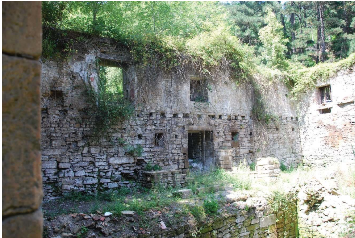
Figuras 11 y 12: Fachada principal e interior de la Torre de Oka (Imágenes Centro de Patrimonio Cultural de GV-EJ).
