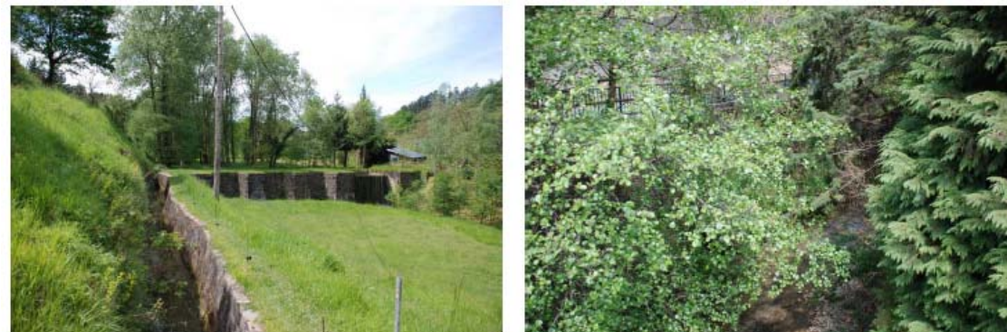
Azud y canal de derivación de aguas en Zugastieta
