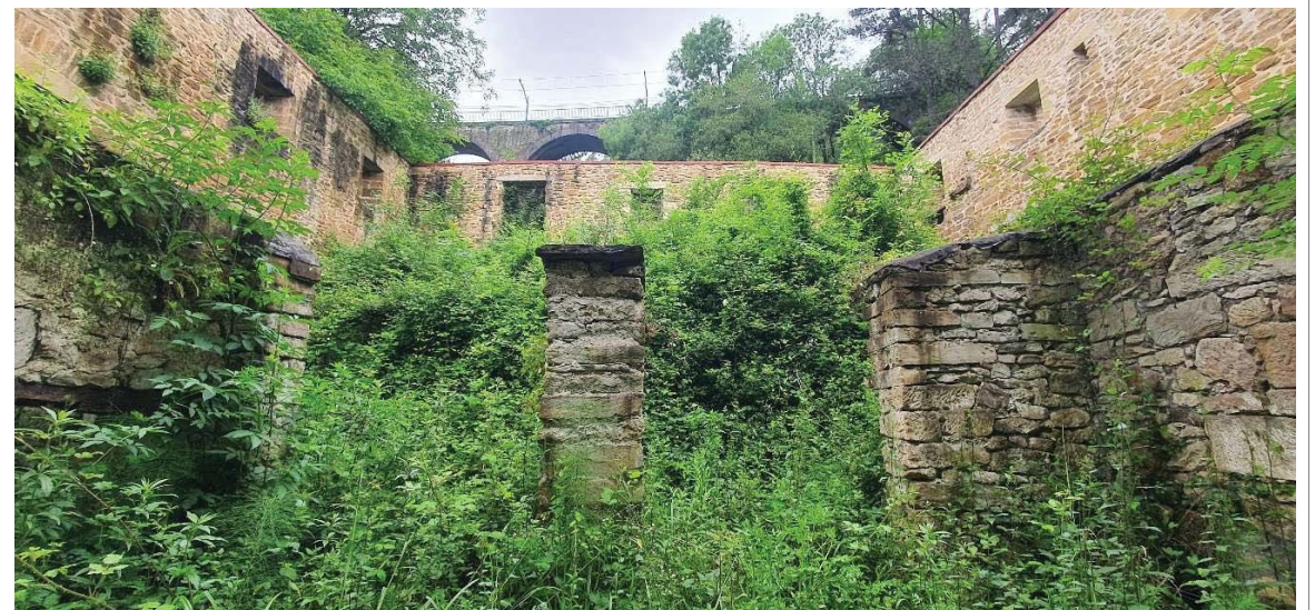
Figuras 14 y 15: Estado de la vegetación durante la prospección del entorno de la Torre de Oka.
