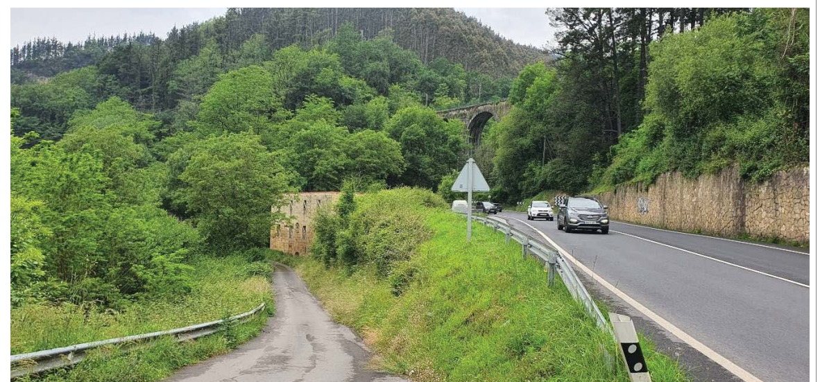
Figuras 6, 7 y 8: Detalles de la Torre de Oka con respecto a la actual BI-635.
