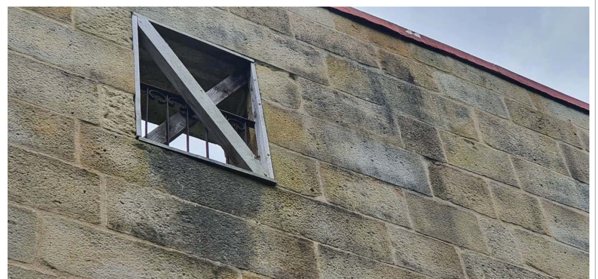
Figuras 30, 31 y 32: Fachada principal. Figuras 33, 34, 35 y 36 (siguiente página): Fachadas laterales.
